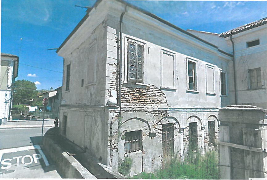
Figura 2 - Vista dell'immobile - vista da sud-ovest – la nord.
